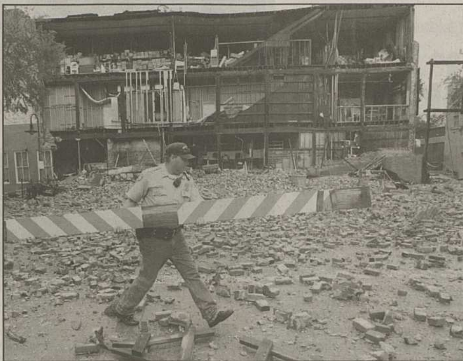
A Galveston, un policier s'apprête à placer une barricade pour interdire l'accès à un bâtiment qui a été détruit par le cyclone. KEYSTONE
