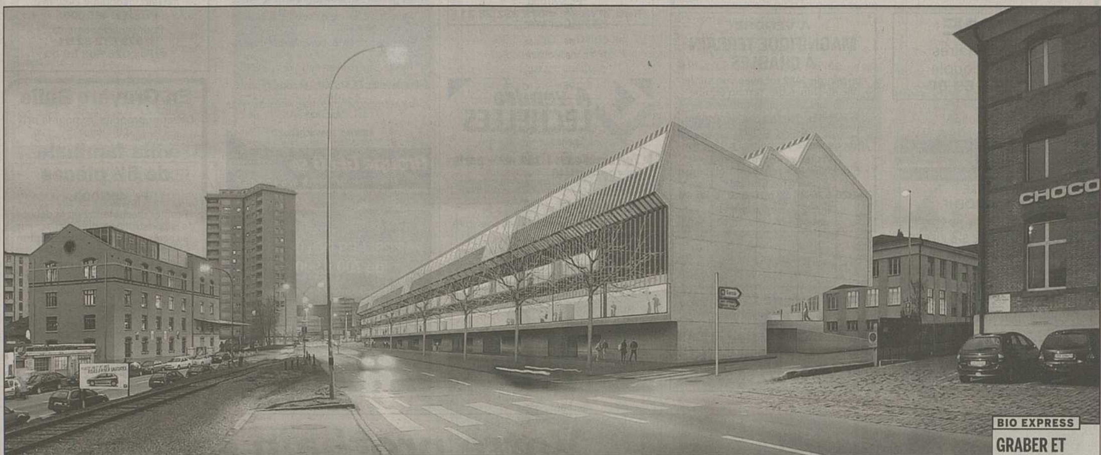
La future Ecole des métiers de Fribourg, avec sa silhouette particulièrement reconnaissable, et le porte-à-faux dans l'un de ses angles. DR
